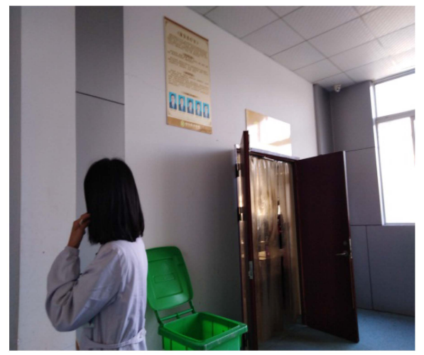
DSA 机房北侧
