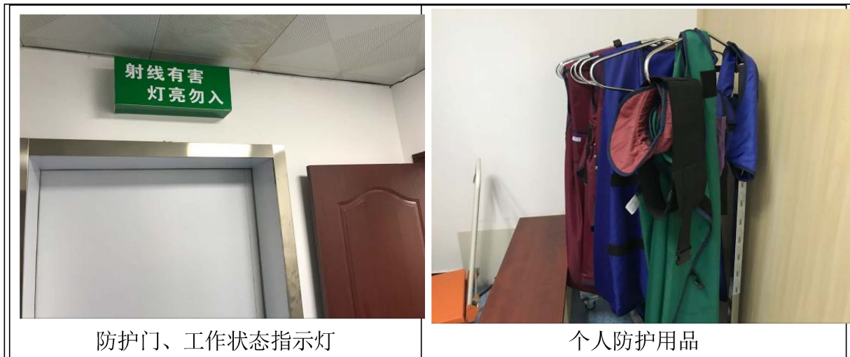
图 8-1 本项目 DSA 机房周围环境现状照片
