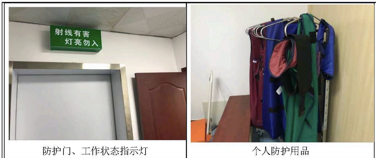
图 8-1 本项目老院区 DSA 机房周围环境现状照片
